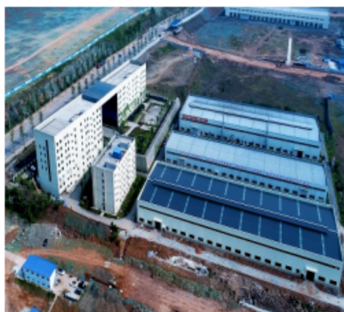
现有项目一期、二期已建成厂房
