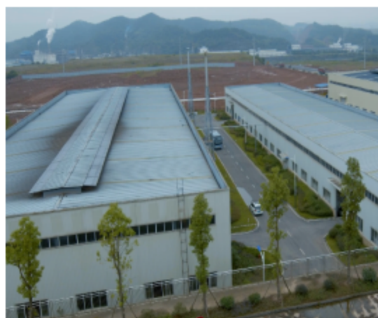
现有项目一期、二期已建成厂房
