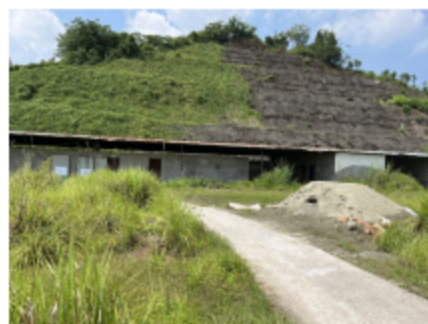
一期工程一般工业固废暂存间设置情况
