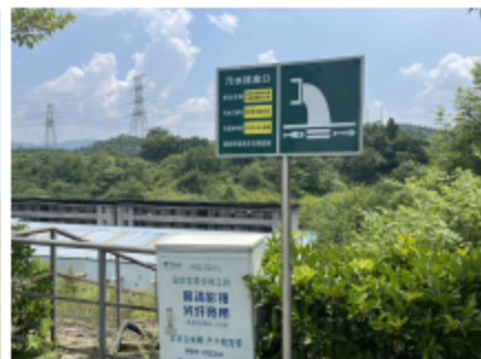
现有废水总排放口 (DW0001)
