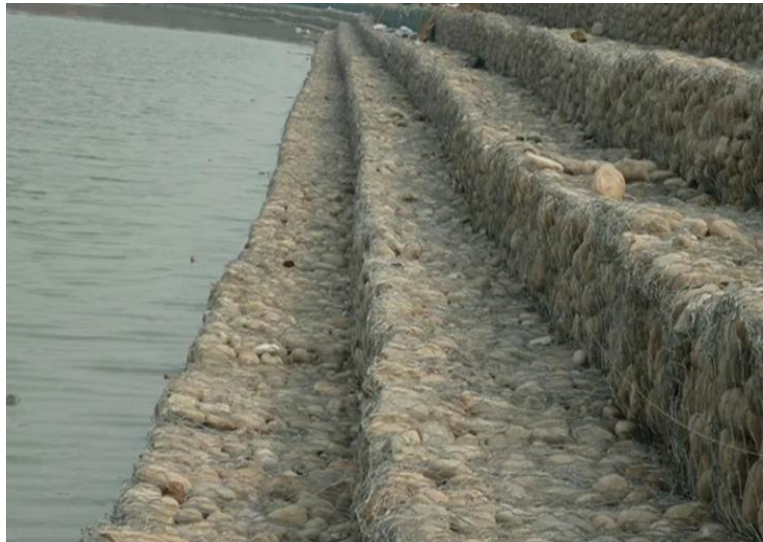
图 2-5 大块石抛填和格宾石笼护坡现场照片
